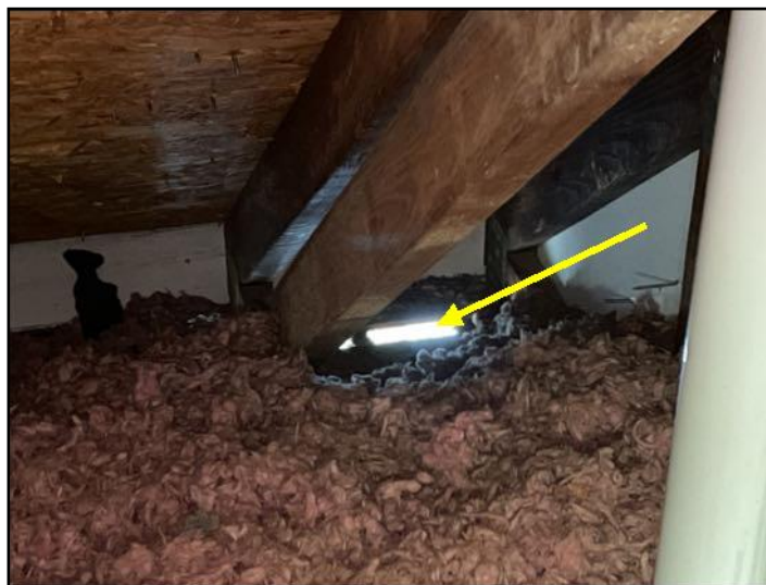
Soffit vent
